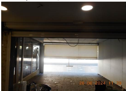
Visita inspecció STM, data 26-06-24
