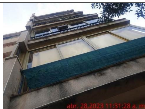
Zona lateral dret de l'edifici
