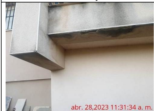
Zona lateral dret de l'edifici
