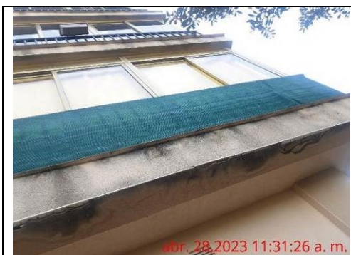
Zona lateral dret de l'edifici
