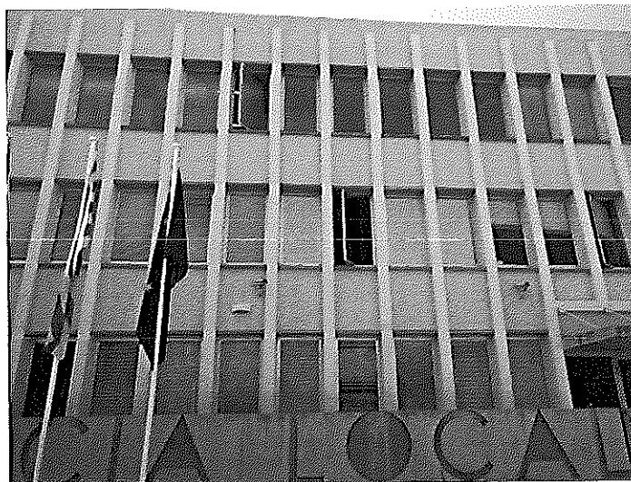
Sud-est (Façana principal)
