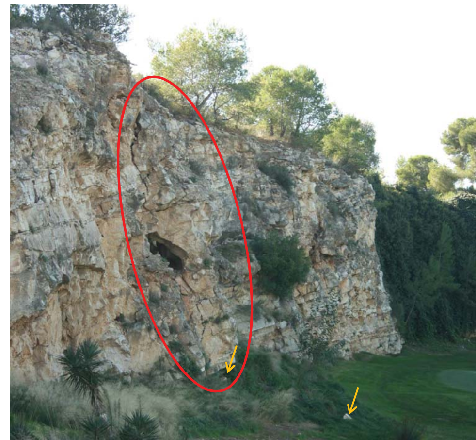
Fotografia 5. Detall del front sud de la pedrera del Cendra. S'observa una massa de roca calcària individualitzada (cercle) i un parell de petits blocs caiguts al peu (fletxes).
